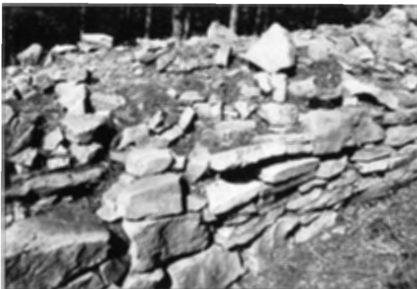
Foto 27. Muralla del poblado de Intxur (Albiztur-Tolosa).
